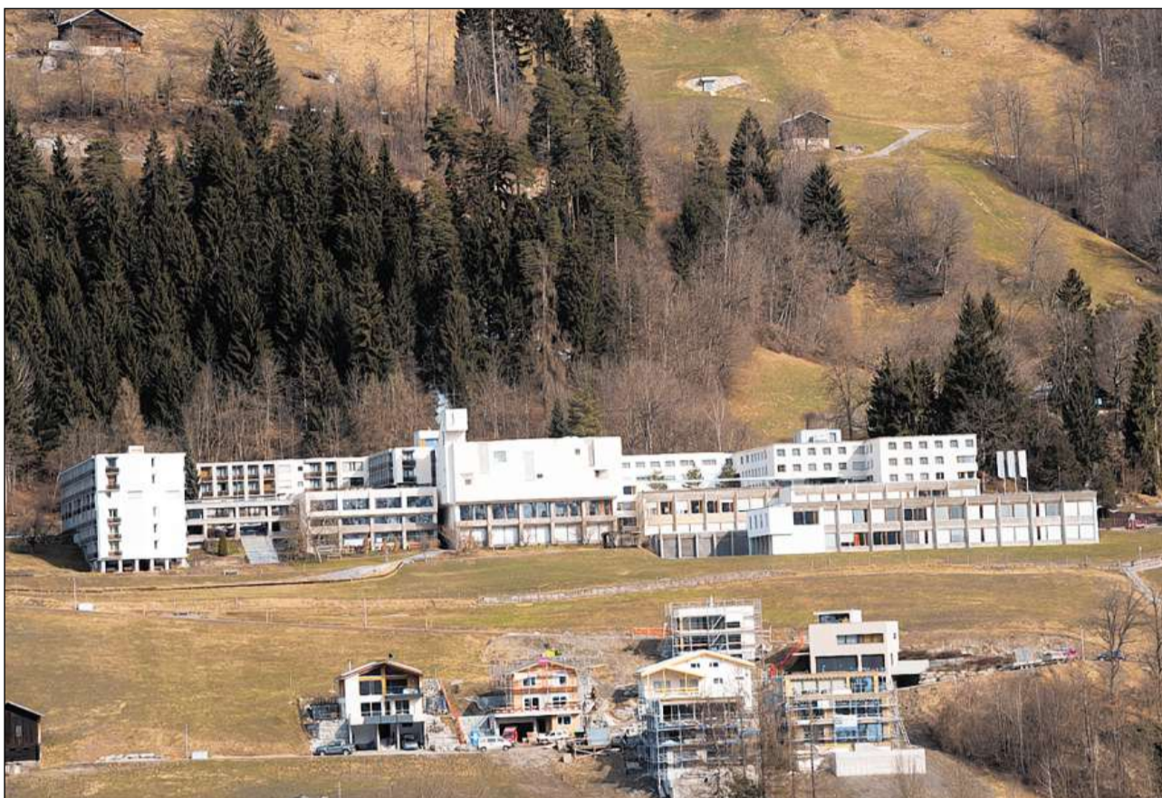
Il bajetg claustral a Glion (terminà il 1970) cun scola ed internat (1973).
