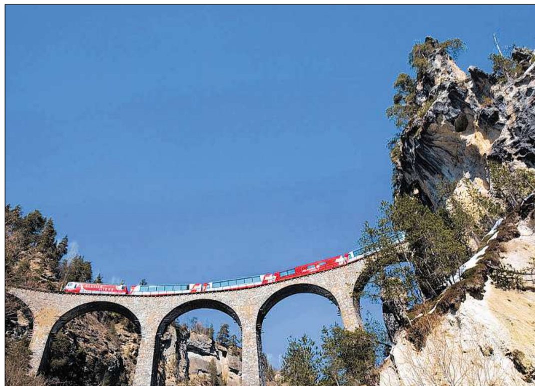
L'enconuscent viaduct sur la Landwasser al nord da Filisur.
