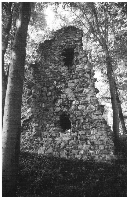
4: Neu-Habsburg/Meggen LU. Mauerrest eines Rundturmes.
