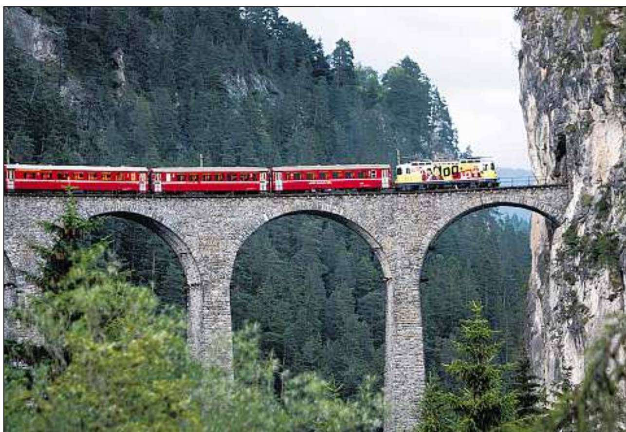
L'enconuscent viaduct dal Landwasser tranter Schmiten e Filisur.
