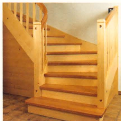
Eingestemte Wangentreppe, viertelgewandelt, geschlossen, Handlauf und Wange mit Krümmling
