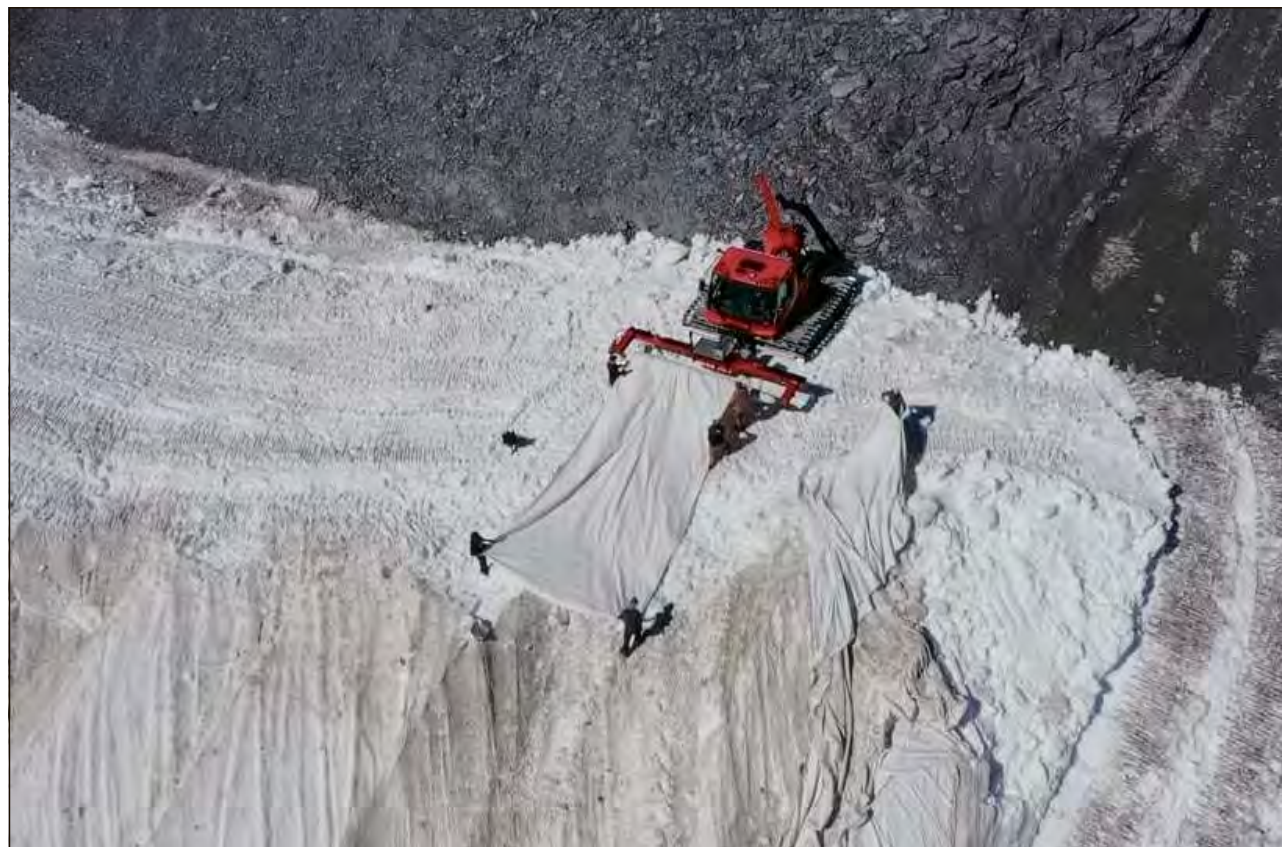
Dapi il 2006 vegnan protegidas cun tailas onn per onn parts dal glatscher dal Vorab per pudair far pistas.
