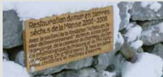
Sanierte Trockenmauer in Charmey FR
