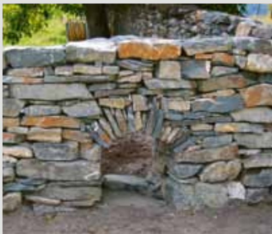
Wiederaufgebaute Trockenmauern in Fürstenu GR
