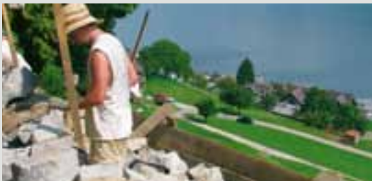
Trockenmauer-Bau in Ennetbürgen NW
