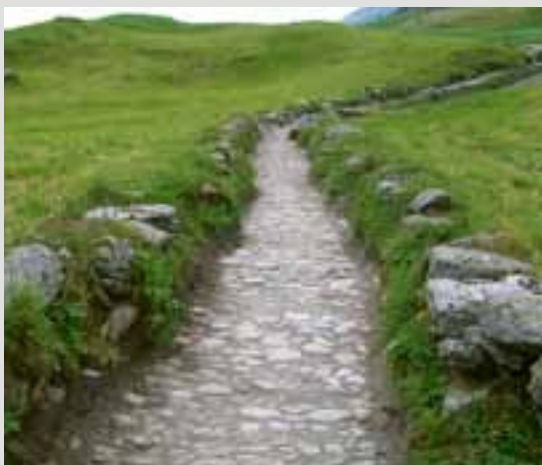
Freigelegter alter Furkaweg bei Hospental UR
