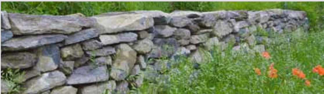
Trockenmauer in der Gemeinde Wartau SG
