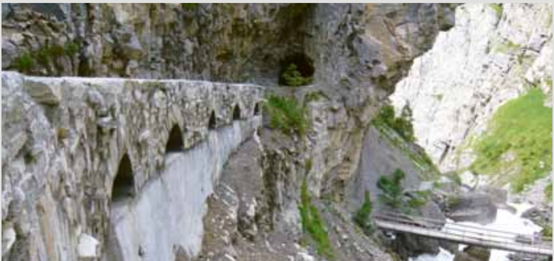
Reparierte Brüstungsmauer am Weg ins Gasterntal BE
