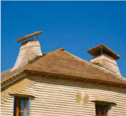
Toiture en tavillons, maison «Le Recorbez», Vaulion VD
