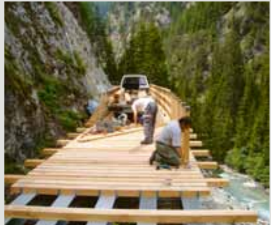
Erneuerte Starlerabrücke, Alte Averserstrasse GR
