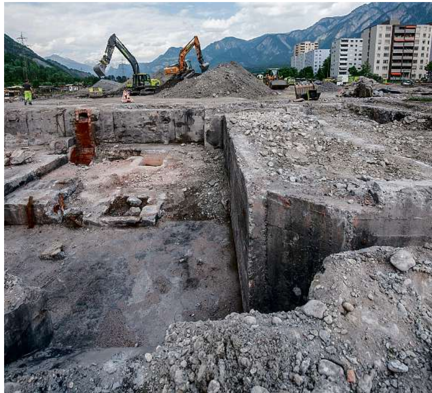
Tar la sanaziun dals schrebertins da Cuira l' onn 2015 han ins chattà pliras tonnas da metals grevs e diesel en il terren. Tenor in studi da l' Universitad da Basilea è terren toxic – er en betg pitschnas dosas – in grond privel per il svilup dal tscharvé dad in uffant. FOTO OLIVIA AEBLI-ITEM
