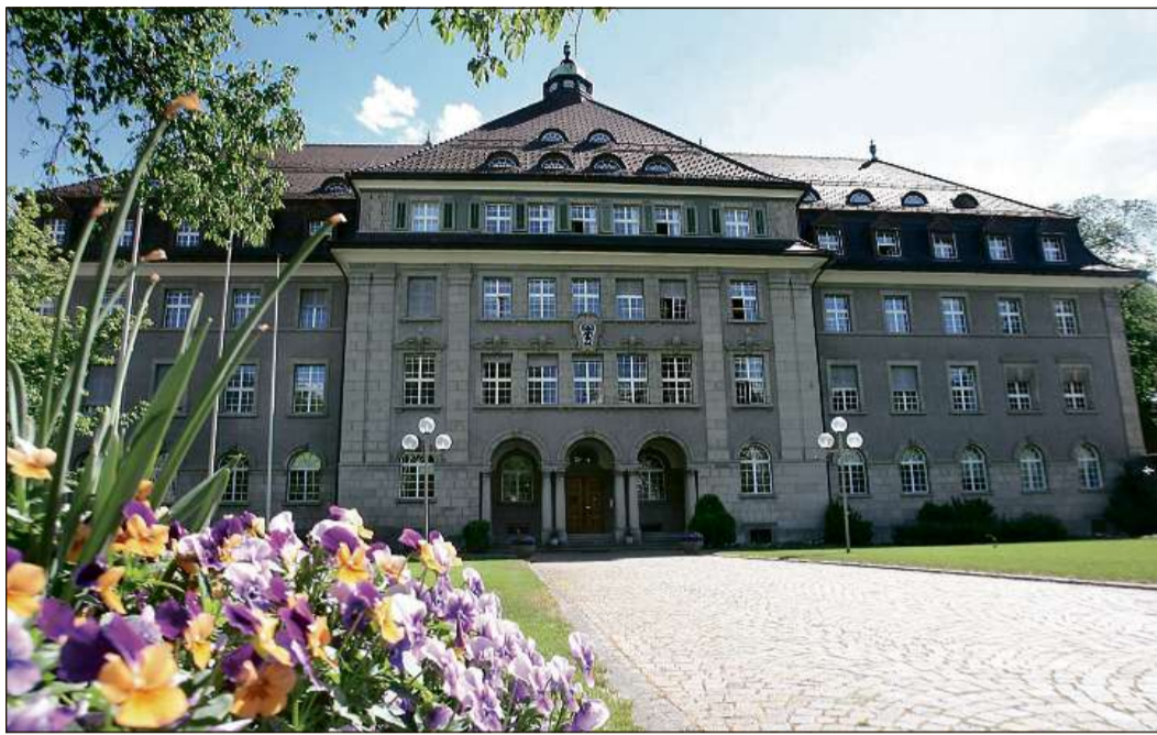
Il bajetg da l'administraziun da la Viafier Retica è vegni construi en il stil grischun. FOTO N. PITARO
