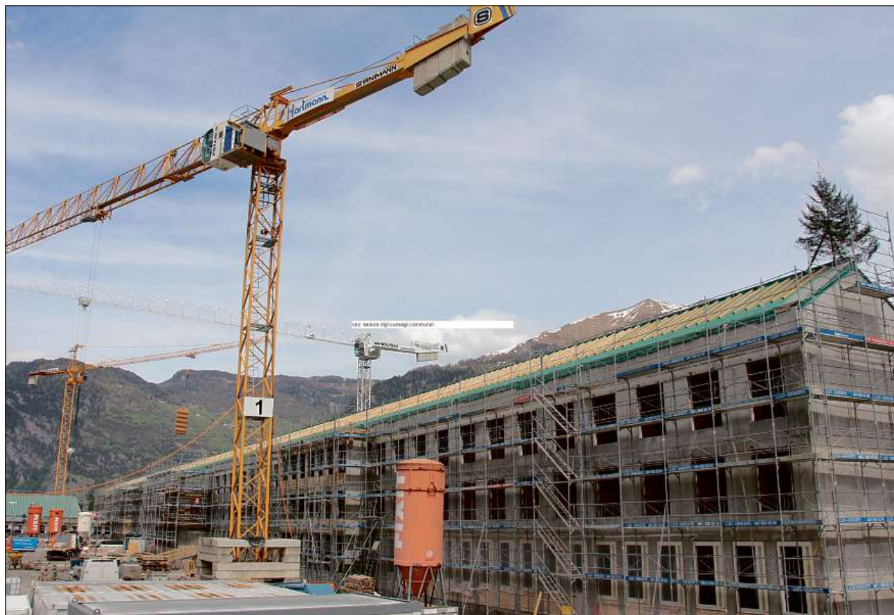
Dimensiuns immensas per la construcziun da la nova praschun a Cazas/Realta.
