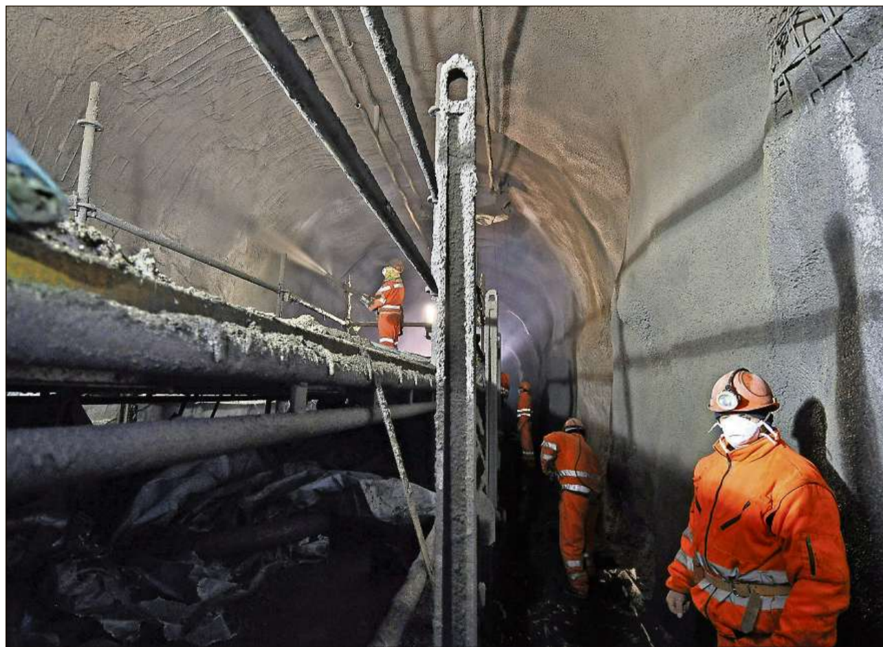
Il plazzal dal tunnel da l'Alvra è er collià cun lavurs da sanaziun e da mantegniment.
