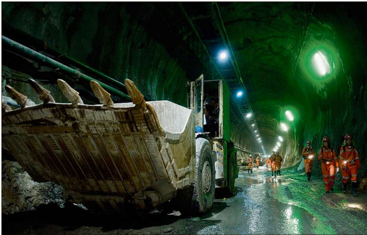
Lavurs durant la construcziun dal tunnel da basa da la NEAT.
