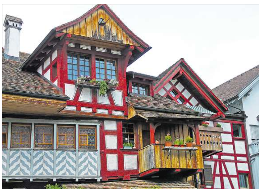
Chasas cun armadura da travs (sco qua ad Arbon) en tipicas per la Svizra dal Nordost.
