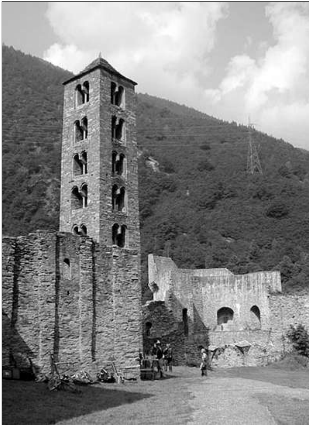
Il signuradi da Mesauc fascheva part da las Trais Lias dapi 1480. 1526 hani ordinà da demolir ses chastè. Ins leva impedir ch'in inimi penetrass en quella fortezza e la duvrass sco basa militara. MAD
