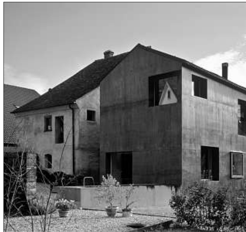
La chasa d'abitar e l'atelier Casascura. La part nova da la chasa concepida en betun che è colligiada cun la chasa viglia fuvà oriundamain in uigl ord diever. FOTOS KEYSTONE
