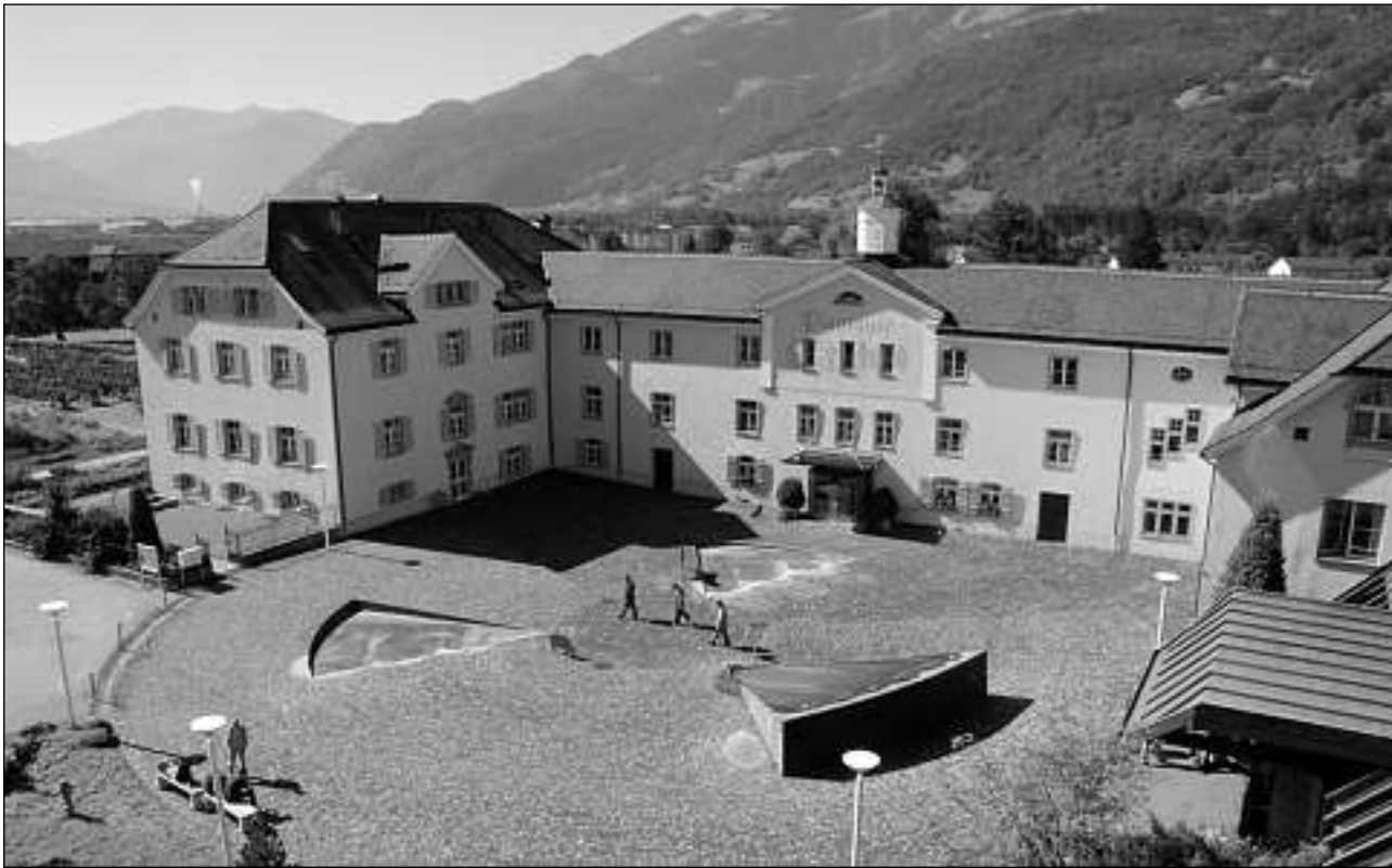
Vista sin l'edifizi principal dal «Russhof», construi il 1811 da Thomas Lareda.
