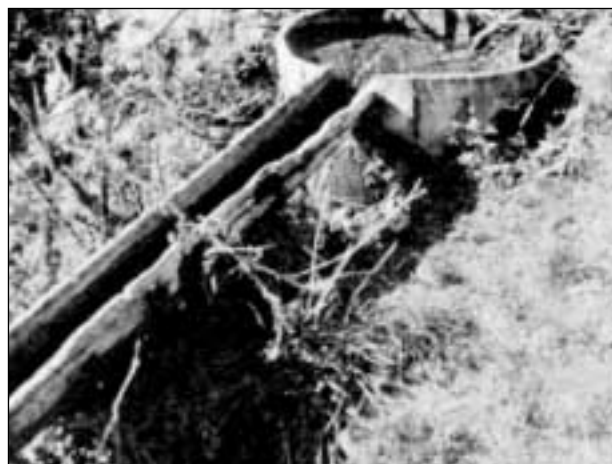
Butschin per tschiffar l'aua cun ina chanal da lain che maina tar in bigl a Schlans.
